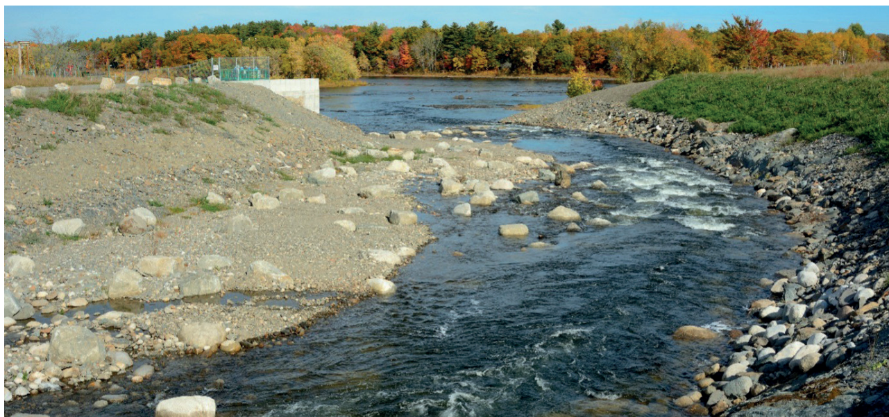
Kuva 3 | Esimerkki luonnonmukaisesta kalatiestä isossa joessa. Kalatien mittakaavan on seurattava joen kokoa. Kuva Panu Orell.
